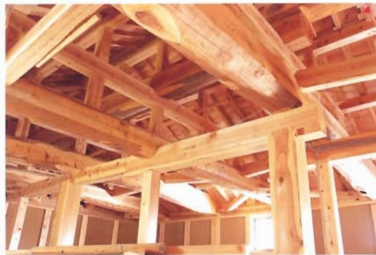
材料の重さと梁の組み合わせて 地震や台風に強い構造
