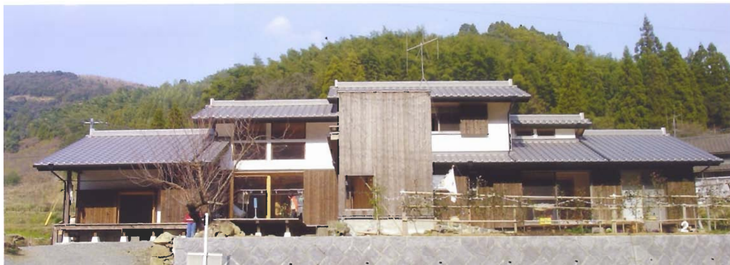
正面の突き出した玄関で 建物がふたつに分かれる
