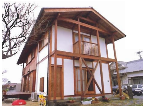
漆喰壁と柿波塗りの板壁のコントラストが、不思議と懐かしさと、モダンさの両面の佇まいを見せます。
