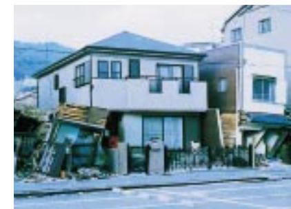
阪神・淡路大震災で被害のなかった木造住宅
