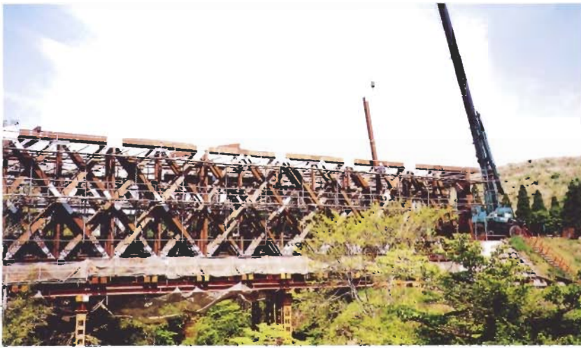
トラス、上弦材取付
